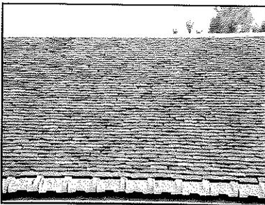
Toiture traditionnelle en tuile plates (rajout de tuiles mécaniques)
